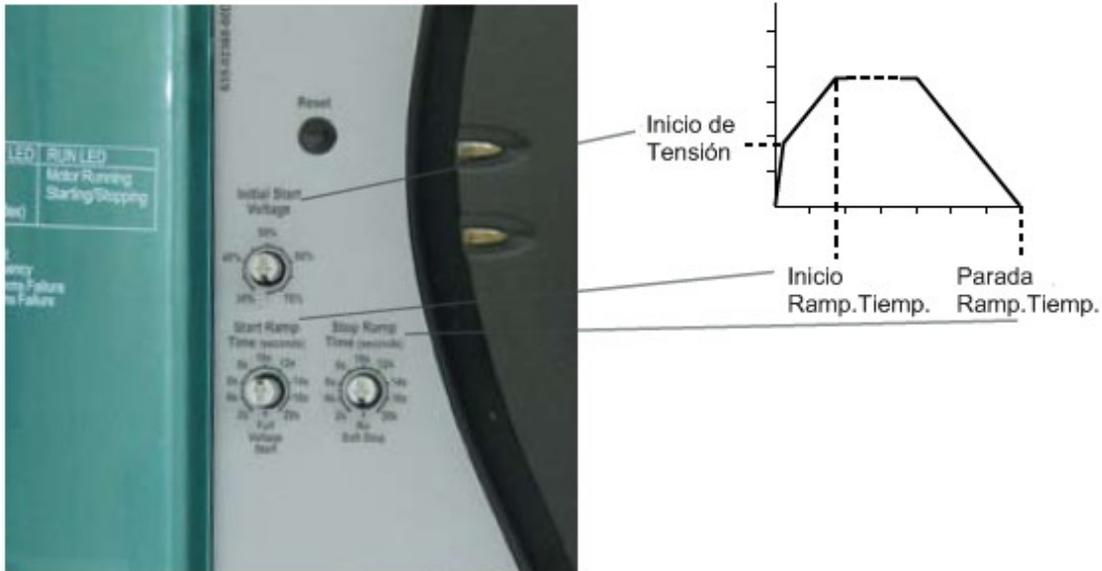
El panel del CSX posee tan solo tres interruptores simples que proporcionan un ajuste adecuado y mayor control para el usuario.
